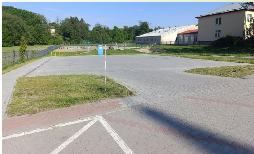
Budowa parkingu w miejscowości Sulów
