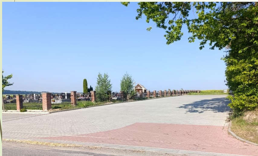
Budowa parkingu w miejscowości Studzianki
