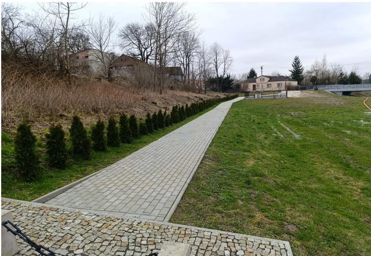
Przebudowa chodnika w miejscowości Zakrzówek
