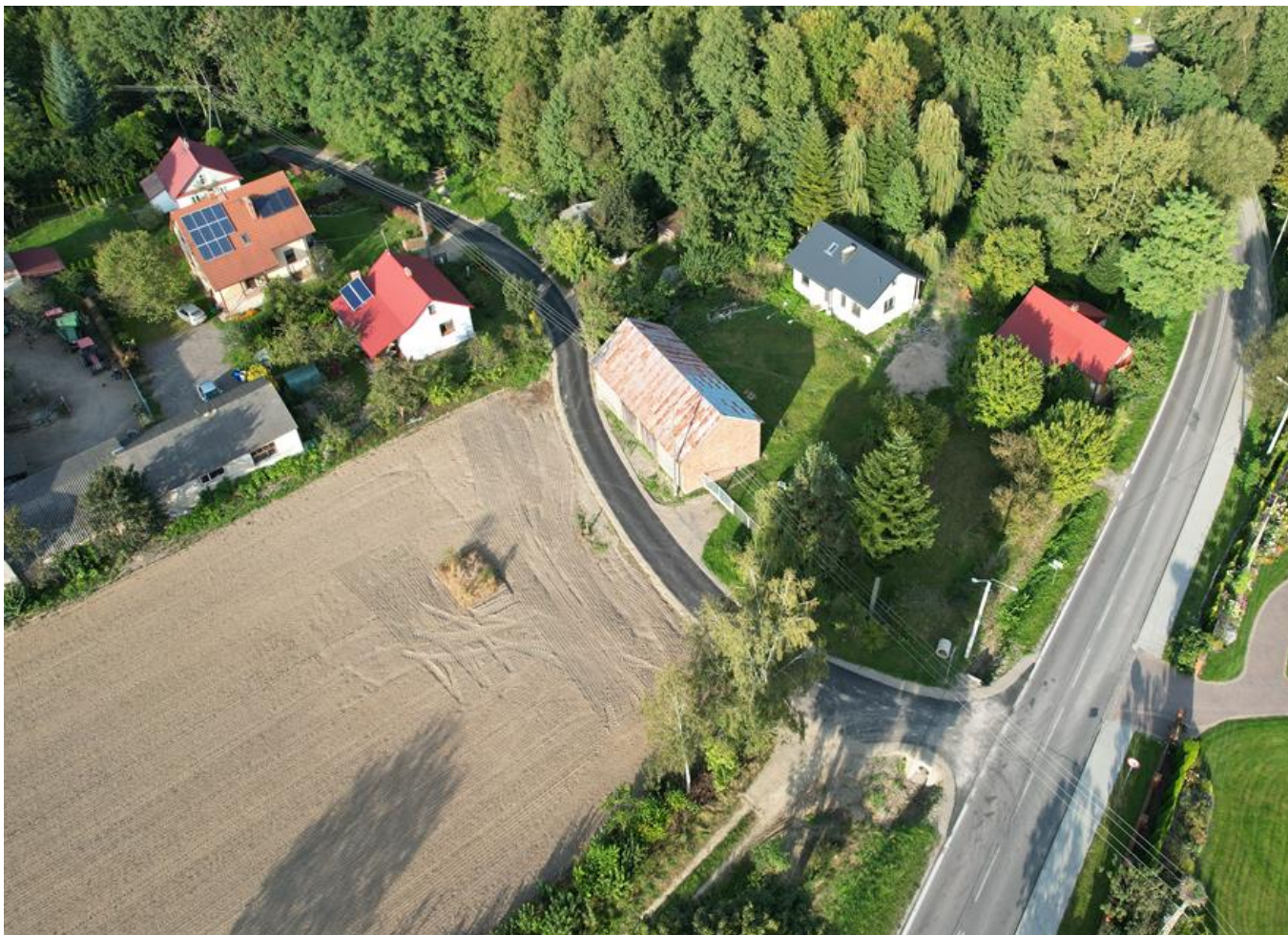
Przebudowa odcinka drogi w Zakrzówku - Wsi
