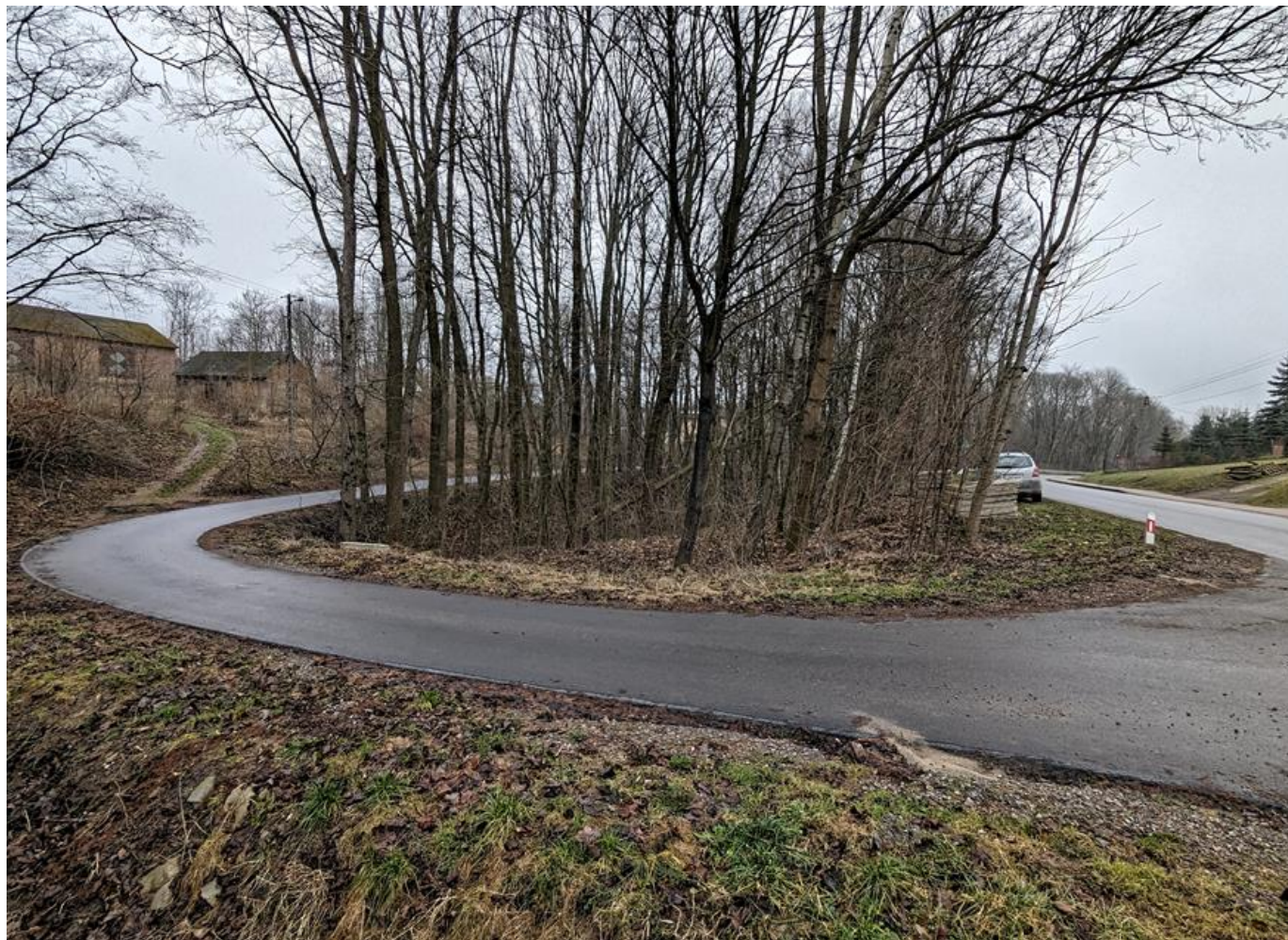
Przebudowa drogi gminnej w miejscowości Majdan - Grabina
