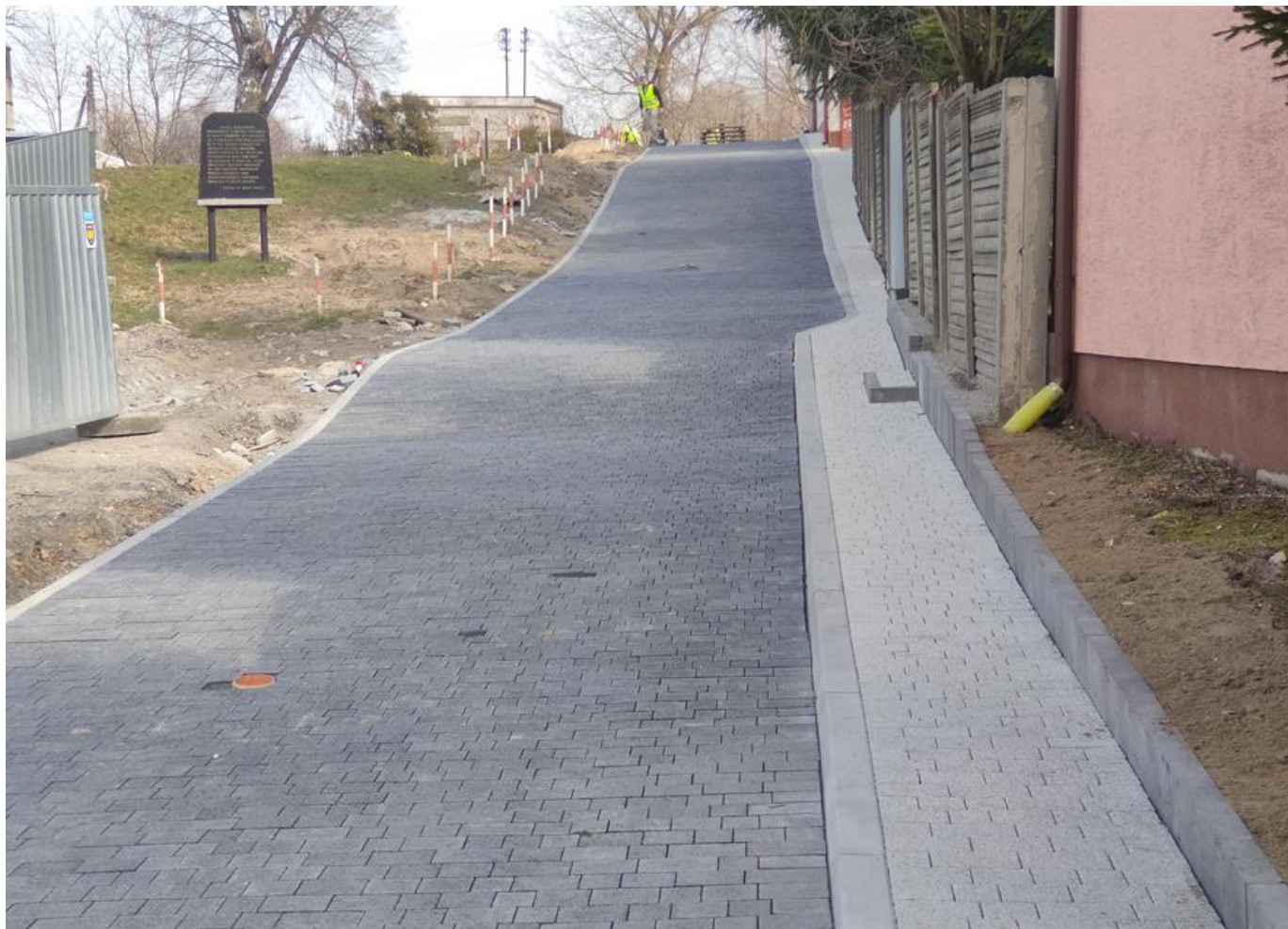
Przebudowa odcinka drogi gminnej w Zakrzówku
