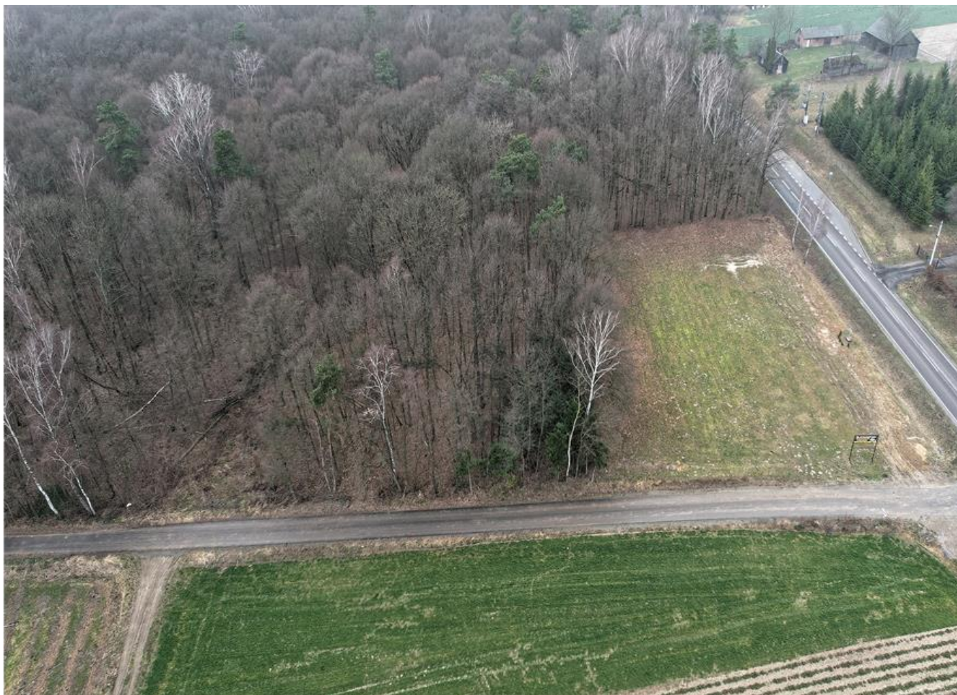
Przebudowa drogi gminnej wewnętrznej Zakrzówek - Rudki
